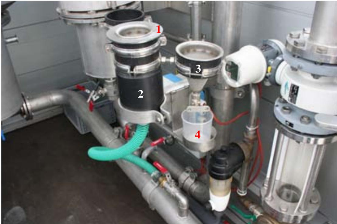
Abb. 16. Reduzierstation mit Probeabfüllung in ein Gefäß zum Transport ins Labor, 1 = kleiner Filter, 2 = Abfluss, 3 = Filterhalterung, 4 = Probengefäß.
