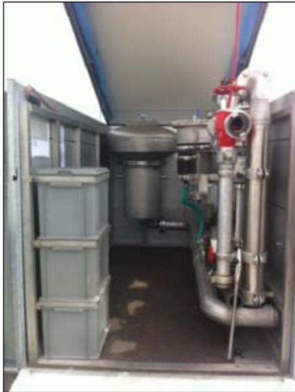
Abb. 22. Zubehör: Stromversorgung in Transportboxen links, Standrohr und Schieberschlüssel rechts.
